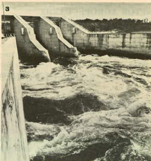
1 — Rio Branco — Acre — obras de saneamento 2 — Crescimento de Vilhena — Rondônia 3 — Hidrelétrica de Curuá-Una
